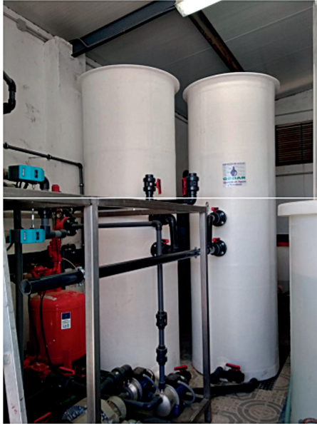
Figura 24: Biorreactores construidos en poliéster-fibra de vidrio.
